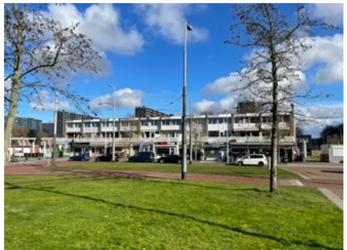
Afbeelding 4: Gevelaanzicht aan het plein
