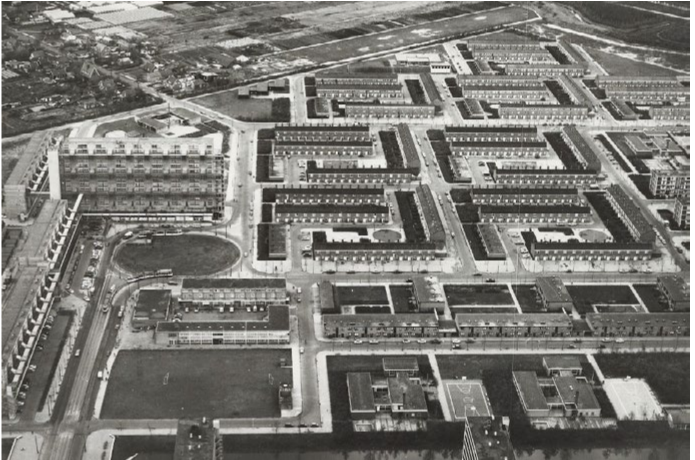
Afbeelding 6: Grandlocatie 1972 met de karakteristiek Hangbrugmaisonnettes en de AUP-typische stempelstructuur
